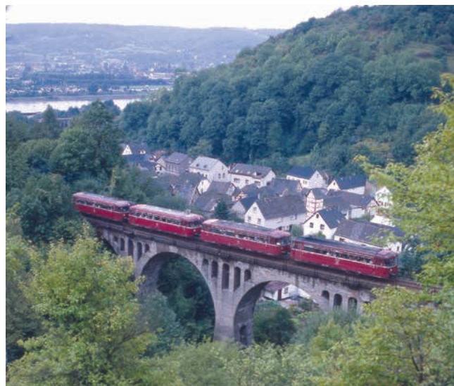
Schienenbusse auf dem Kasbachtaler Viadukt
